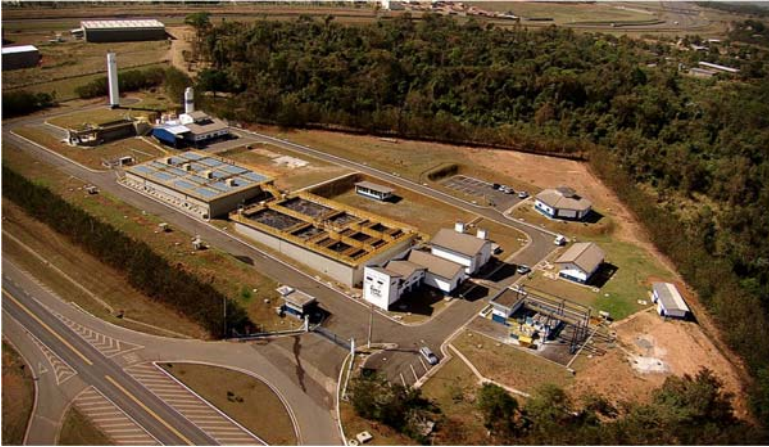
Figura 14 – ETE Águas da Serra – FOZ DO BRASIL – Limeira – SP.
