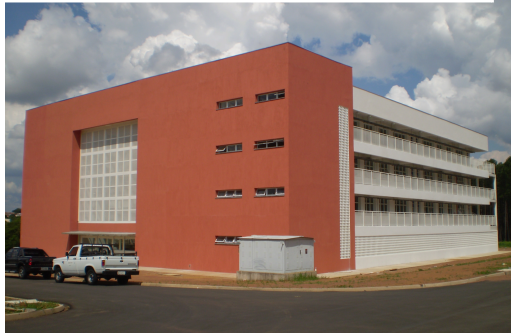
Prédio do IFSC em construção - Campus II
