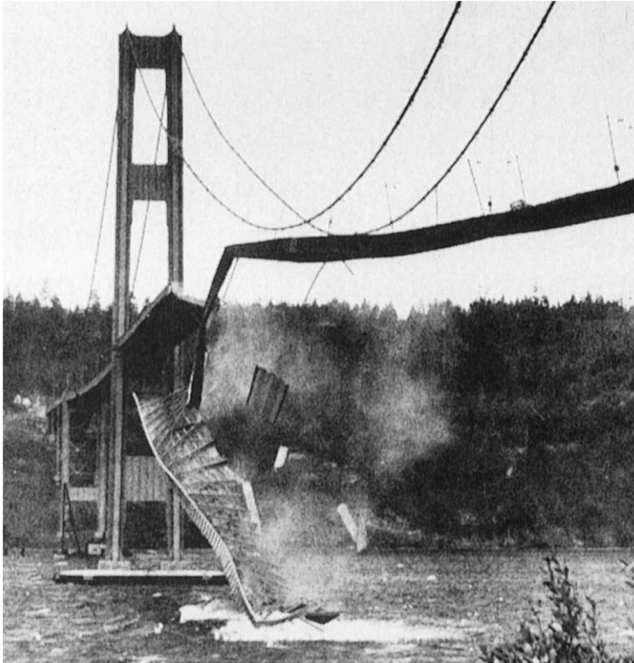
A frequência da oscilação causada pelos **vórtices** alternados provocados pelo vento, coincidia com a frequência de vibração natural da estrutura (**condição de ressonância**).
